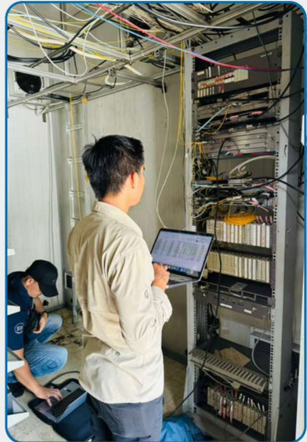
Gambar: Kegiatan Pemeriksaan Stasiun Radio Microwave Link secara Open Shelter terhadap operator seluler
