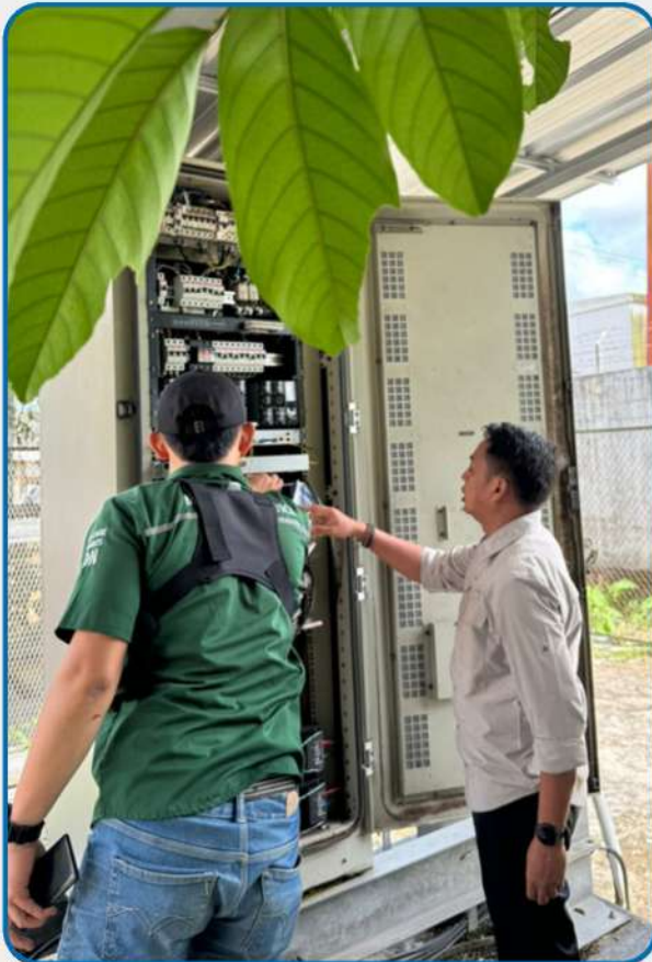
Gambar: Kegiatan Pemeriksaan Stasiun Radio Microwave Link secara Open Shelter terhadap operator seluler
